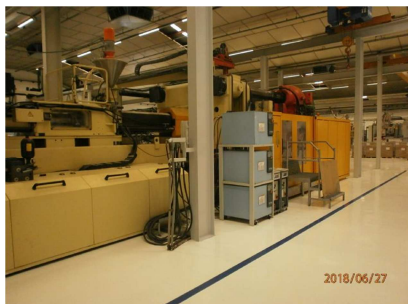
Inyectora termoplástico 1650 ton. con robot.
